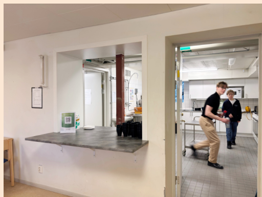
Församlingssalen fick en serveringslucka, mars 2026.
